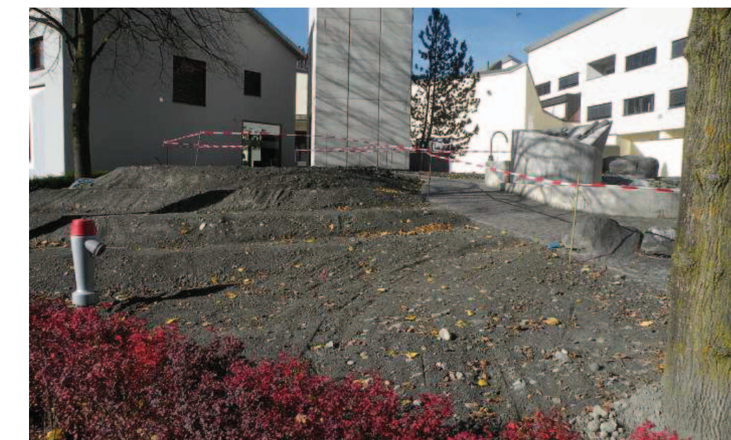
Bild: mk Diverse Umbauarbeiten sollen zu einer Verschönerung des Dorfplatzes führen.
