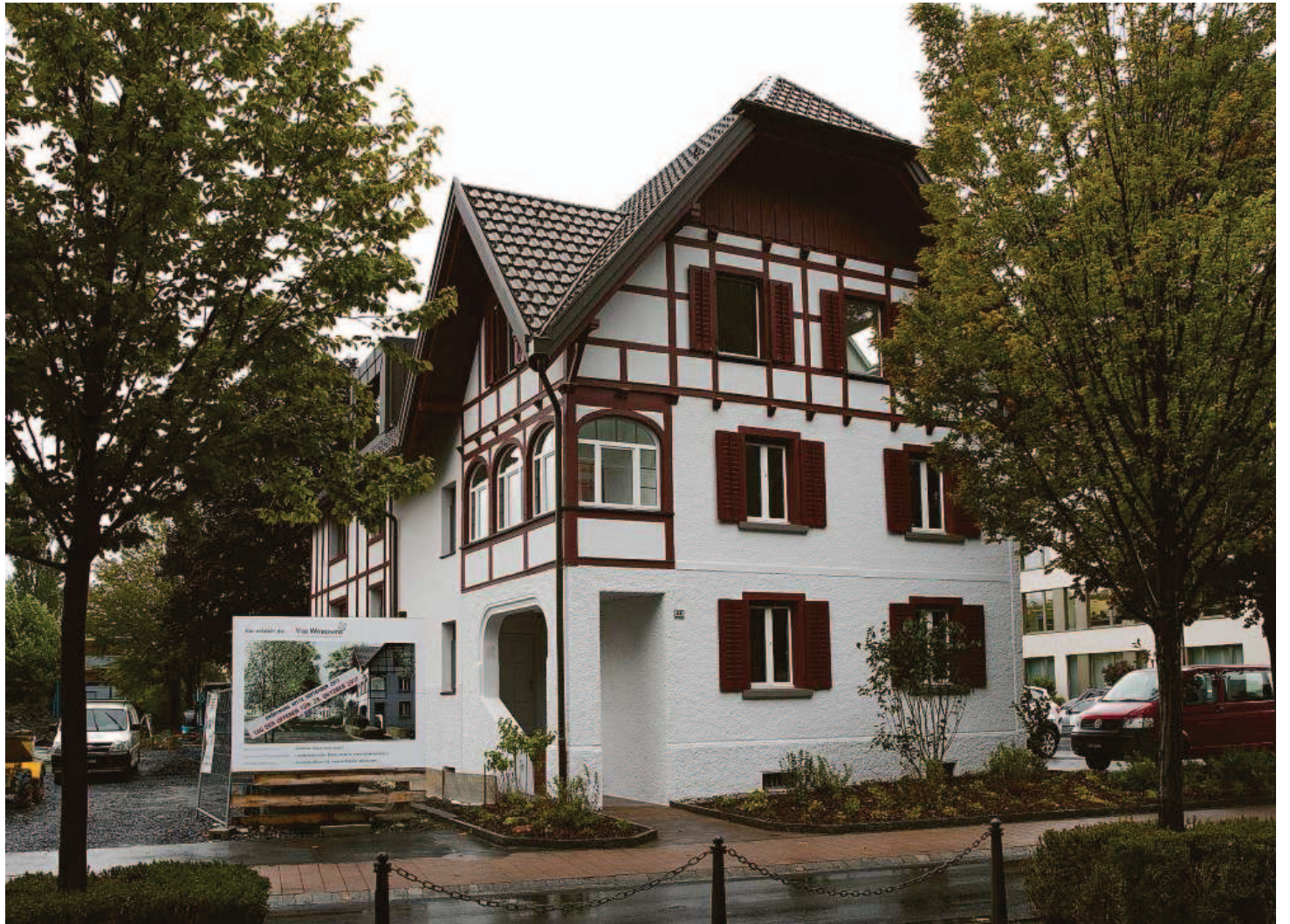
Nach den Umbauarbeiten wurde heute die Banken-Kindertagesstätte Wirbelwind in Betrieb genommen.
