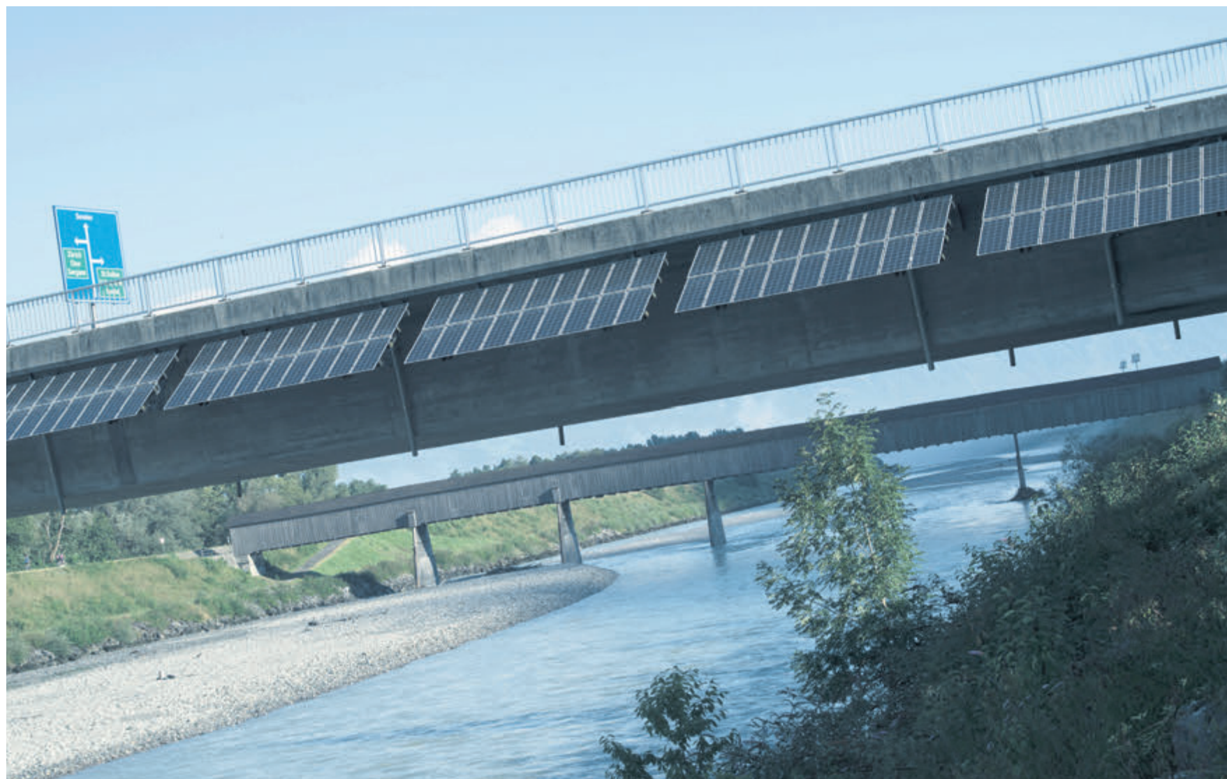
Es geht oft vergessen, dass sich das Land Liechtenstein durch einen breit diversifizierten, exportorientierten Wirtschaftssektor mit einem starken Industriestandort und einem international aufgestellten Finanzplatz auszeichnet.
