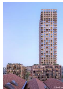
Bild 2: Holzhochhaus «Rocket», Winterthur
